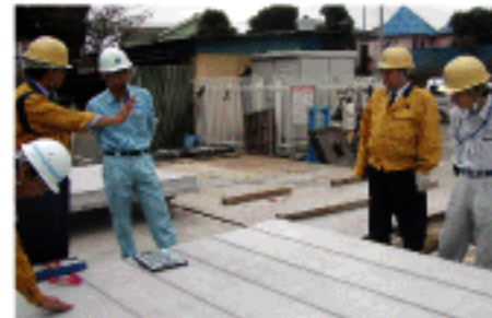
PC盤（外壁）検査立ち会い 外壁の安全性を確認するため、検査を行いました。 （中央右・菊池次長 右端・北田課長補佐：藤井撮影）
